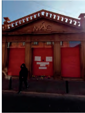
Figura 8. Intervención de la colectiva La Castilla Combativa . Fuente: https://www.facebook.com/colectivalacastilla/photos/pcb.2806461052946393/2806460982946400
